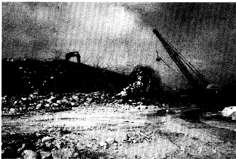
Figur 1. Nedrivning af kraftigt armeret betonbro.
