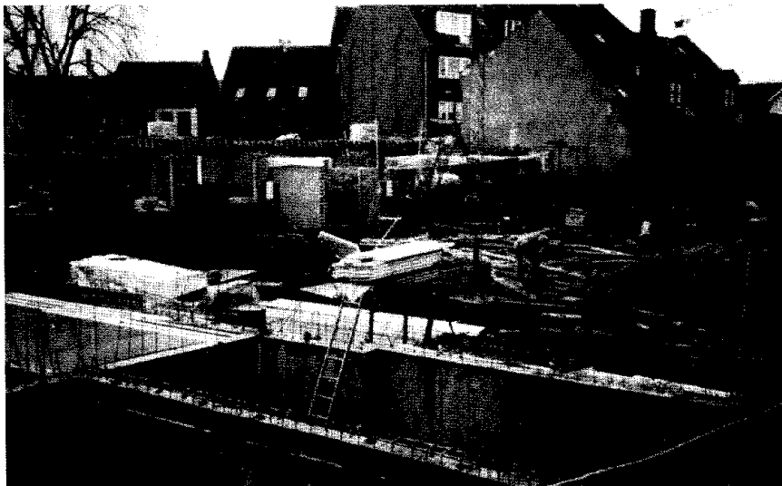
Figur 3. Støbning af kældervægge med genanvendestilslag.
