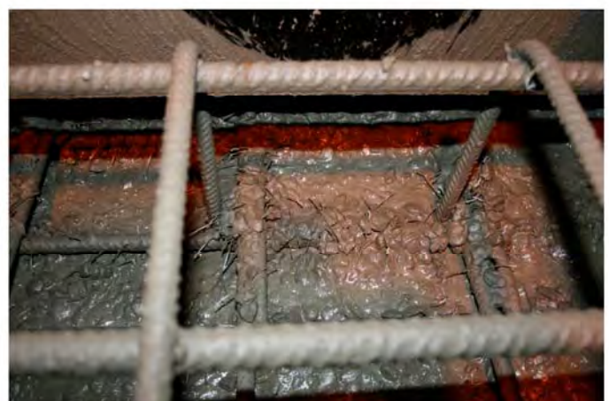
Udstøbning af kantbjælke inkl. stålfibre
