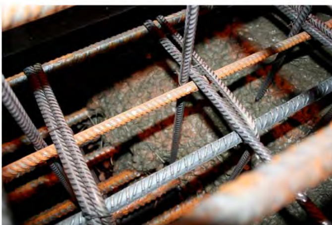
Udstøbning af kantbjælke inkl. stålfibre
