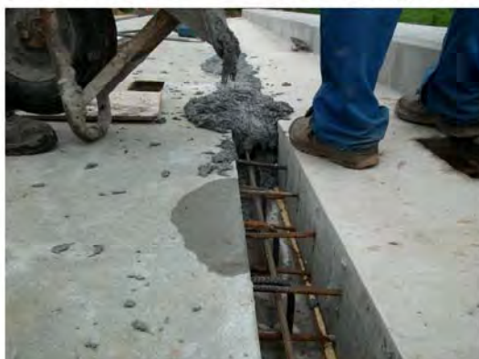
JointCast støbes fra trillebør. Håndvibrator
