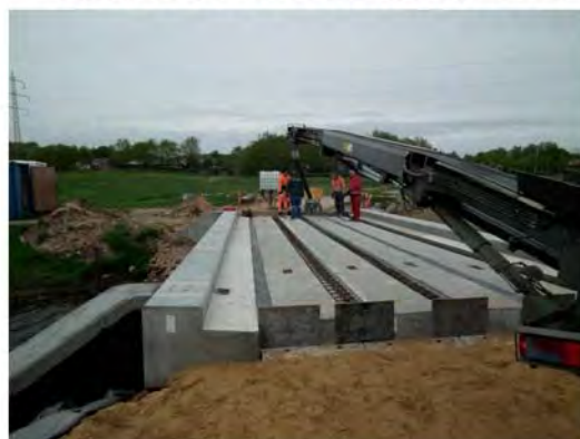
Traditionelle samlinger. Fabriksbeton fra bånd
