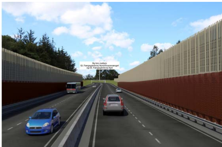
Vejanlæg og støjskærme på Tørslev Hage, set mod vest
