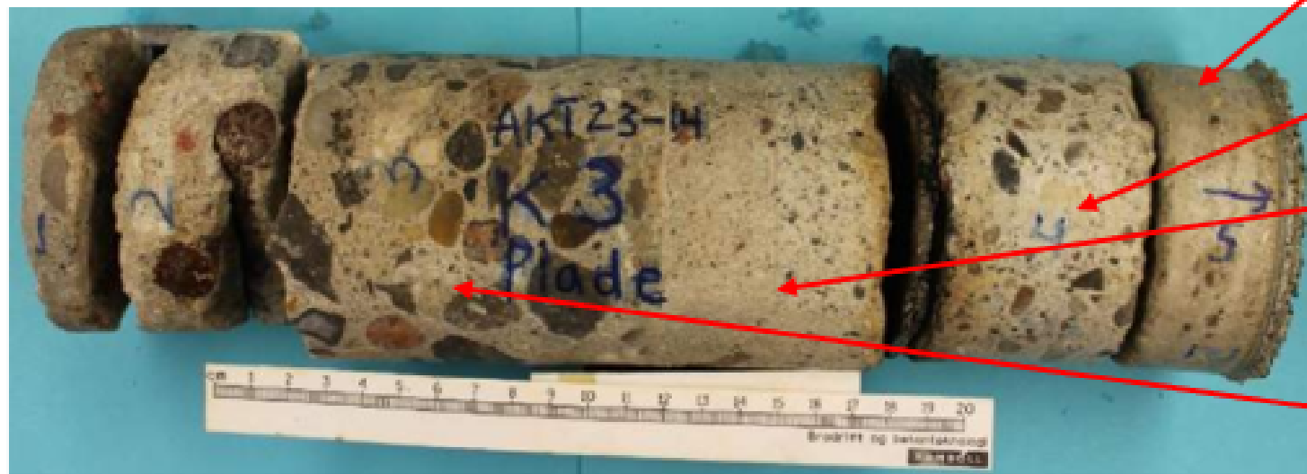
Figur 3-6: Borekerne K3 fra bropladen, boresiden/undersiden af dækket ses til venstre på fotoet. Bemærk den sorte skive ca. 1/3 fra højre, som formentlig er en tidligere fugtisolering på brodækkets overside. Derudover er der en kunstbelægning på det øverste afretningslag (til højre på fotoet).
