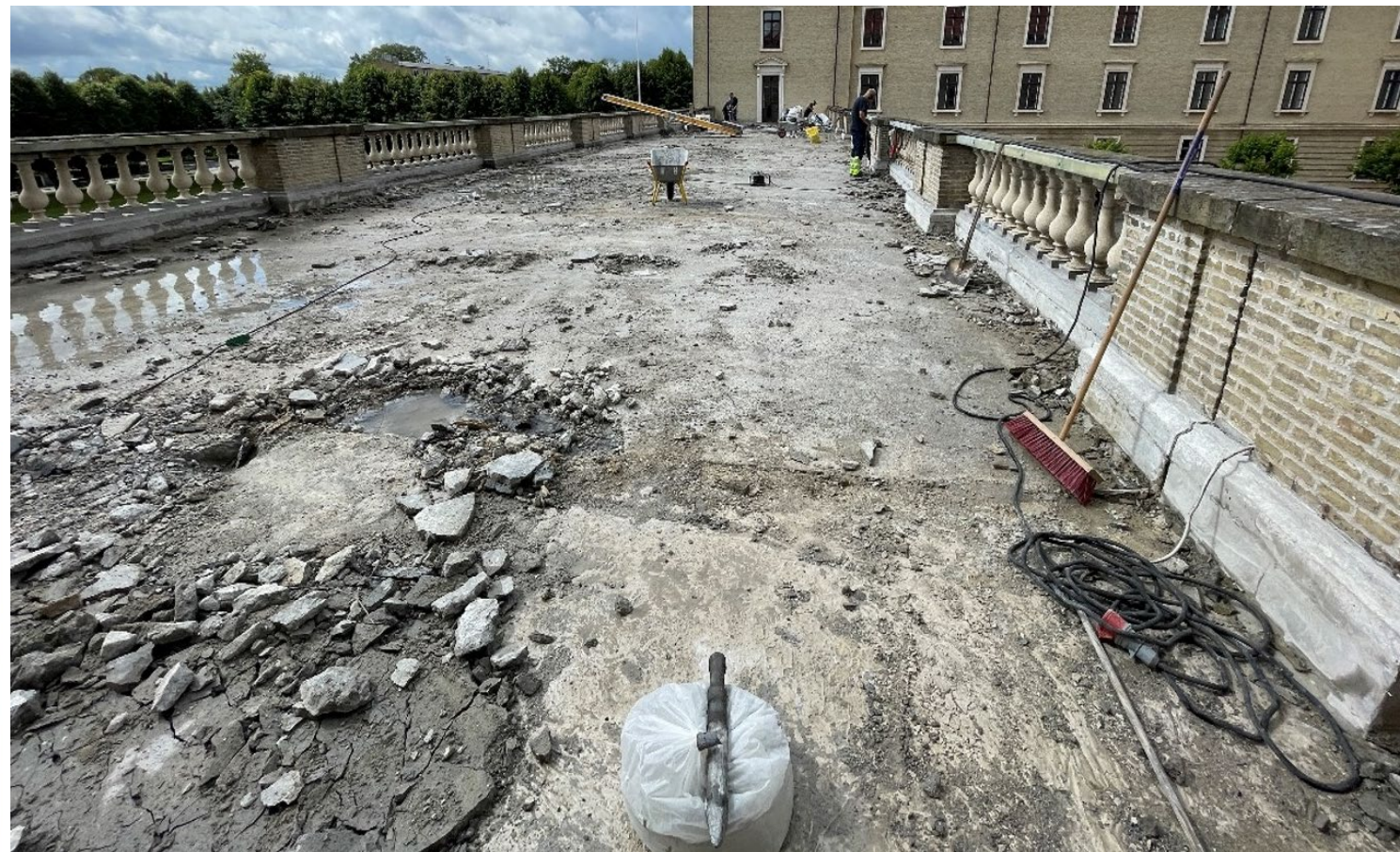
Nedbrydning af det øverste lag "lag 5" af det eksisterende profileringslag pågår.
