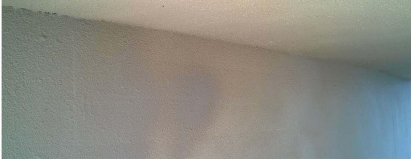
Udsættes **Flexcoat** for regn, tåge eller høj luftfugtighed inden tilstrækkelig hærdning er opnået, kan den behandlede overflade fremstå stribet eller skjoldet. Disse hvide misfarvninger vil aftage med tiden.
