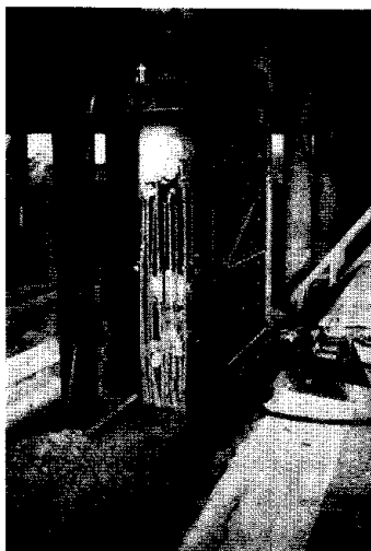
Fig.7: Delvis bortsprængt søjle med aflastningsåg.
