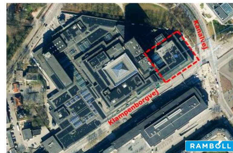
Figur 1: Luftfoto af center med ombygningsområde
