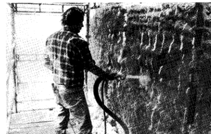
Figur 1: Cellulosefibre »ISOFIBER«, med elektrolyt påsprøjt på en betondekade. Formålet er her en realkalisering af den carboniserede facade, se figur 2. Den samme proces anvendes ved chloridudtrækning og er især anvendelig for undersøder af f.eks. brodæk og højled med betondet chloridudhold. En flydende elektrolyt kan med fordel anvendes ved udtrækning af chlorid fra betonsøjler. Foto: Ervin Poulsen
