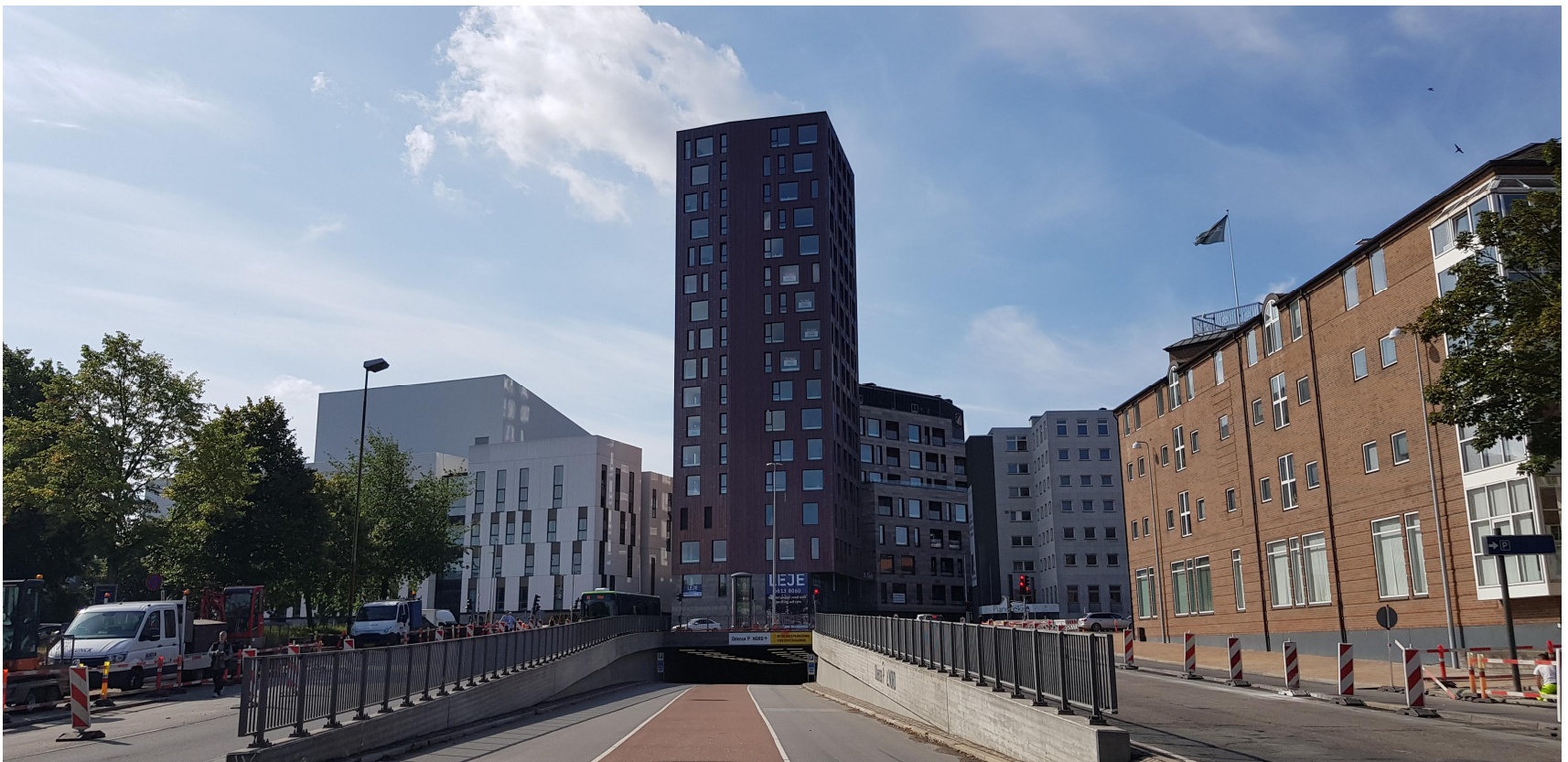
Aflevering af byggeriet, den 26. juni 2019
