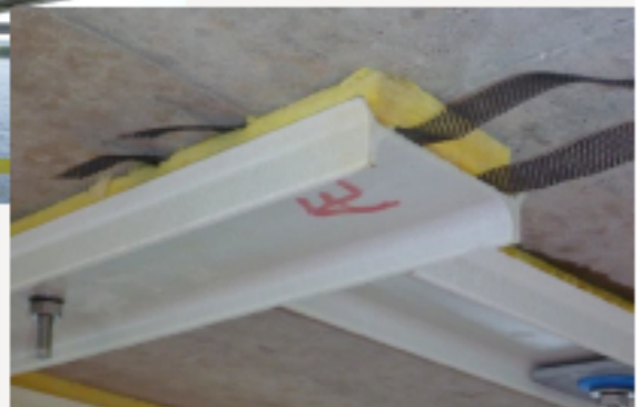
Telpro bånd system: Ti-bånd med MMO og sprøjtebeton dæklag
