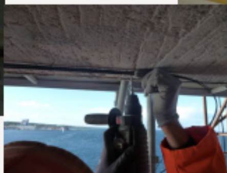
Tape system: Ti-tape med MMO og ledende mørtel dæklag
