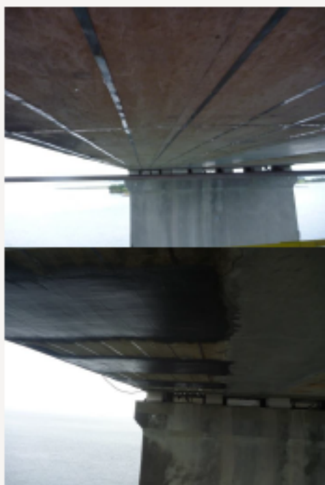
Tape system: Ti-tape med MMO og ledende mørtel dæklag
