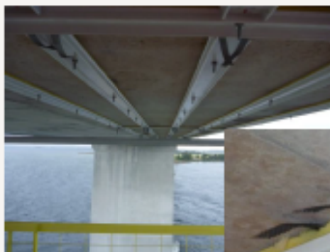
Cassette system: Titan bånd med MMO i kassetter med mineraluld og ledende hygroskopisk væske.
