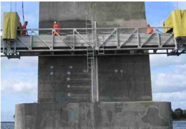
Foto nr. 5 og 6 : Langelandsbroen. Pilotprojekt med katodisk beskyttelse på pille 7 Ø, år 2003.
