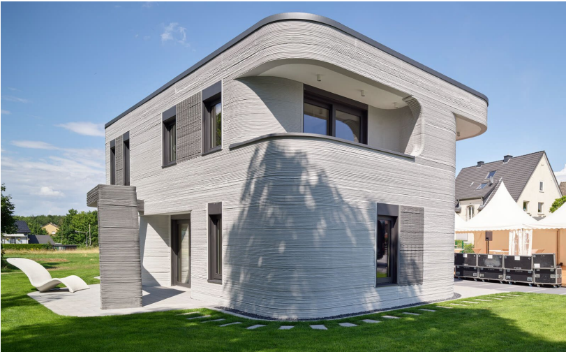
PERI / COBOD BOLIGBYGGERI, BECKUM
