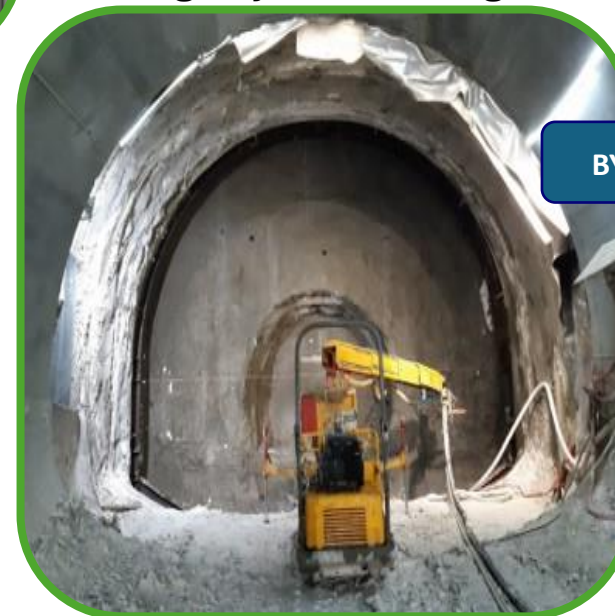
Opførelse af tunneler og skybrudsikring
