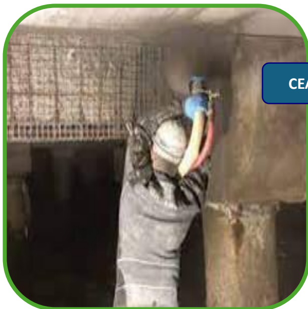
Reparation af søjler og bjælker
