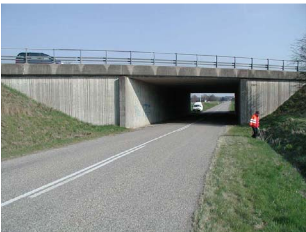
Bro ”nr. 2” : Bro opført 1967. En 38 m lang og 9 m bred underføring. AKR-skader i den ene fløjmur.
