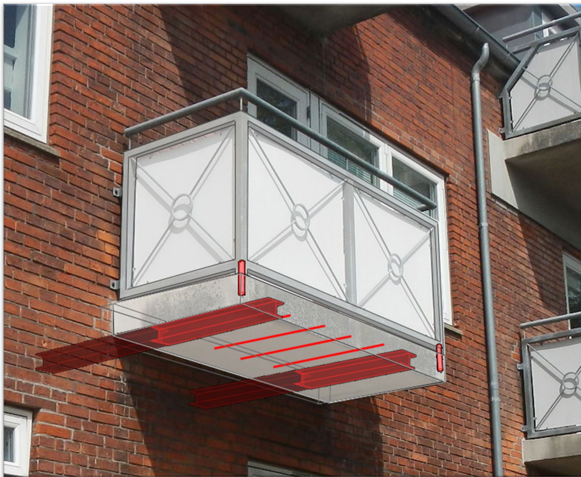
Altan med udliggerjern
