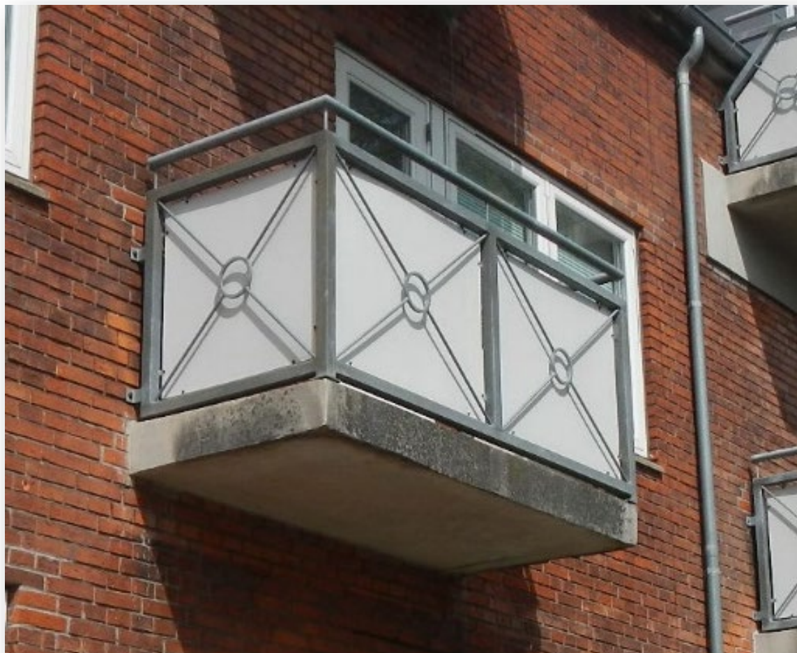
Altan med udliggerjern
